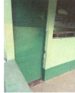
Foto 2: Sustitución de puerta de metal
