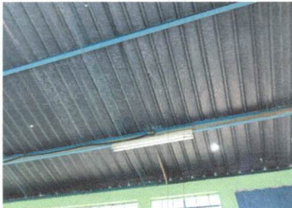
Foto 5: Sustitución de lámpara led
