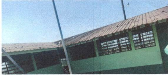
Foto1: Sustitución de lámina
